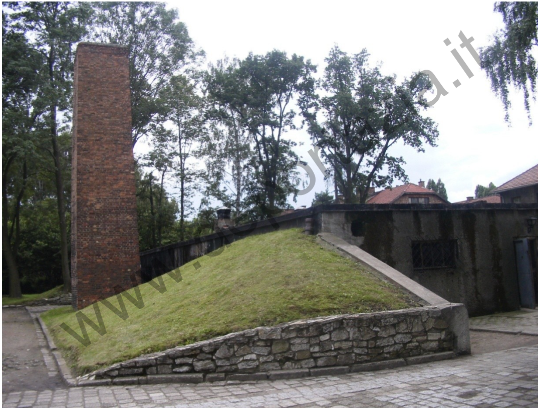
15 – fuori dalla zona dei deportati si trova l'edificio adibito a camera a gas e dotato di forni crematori
